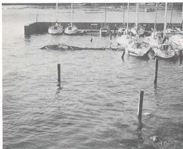
手前にもう一列あったボンツーンは係留の艇とともにバイルから引きちぎられた
