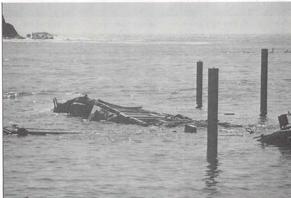
通常はこの正面に堤防があり、このように海は望めない
