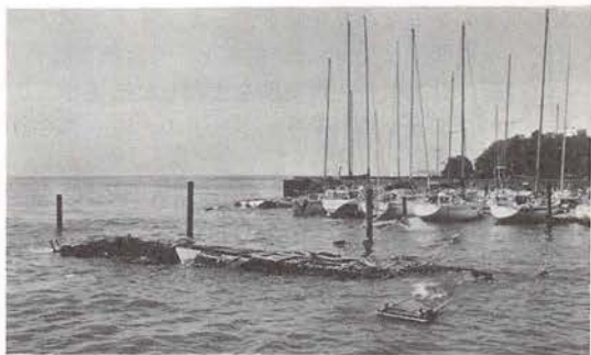
浮き桟橋もこの通り。
