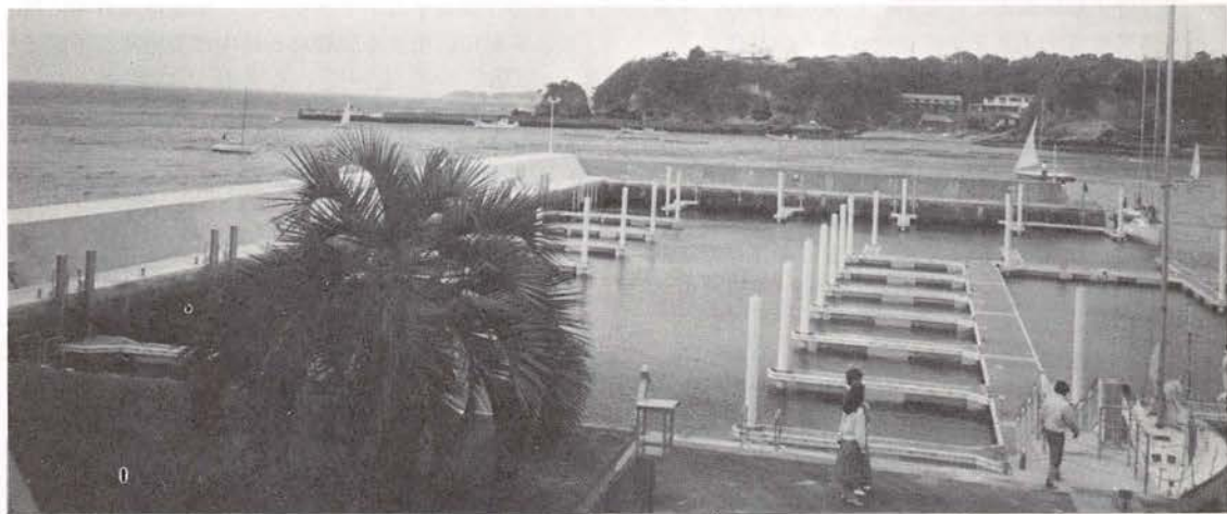
左側の堤防が築かれ、港内も整備された。
