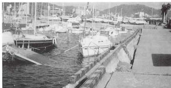
岸壁がくずれ、ボンツーンへの架け橋も海へ…
